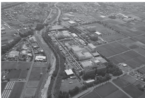
図2 群馬地区航空写真(手前が本社・技術開発センター)
