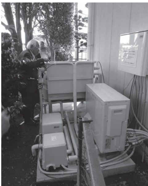
写真 1 群馬電機(株)に設置された オープンループ式地中熱利用空調システム
