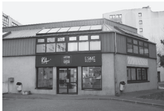
入り口が三つほどある。トイレもきれい。
