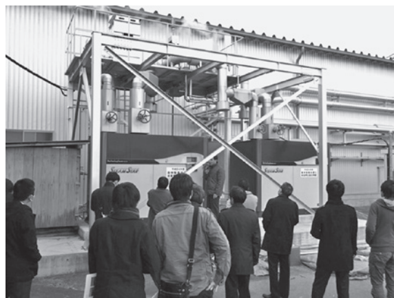
二宮木材(株)本社・工場見学 (スクリー式小規模蒸気発電プラント)
