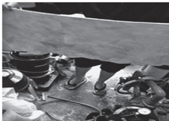
図3 使用後の温泉浄化用繊維フィルター(毎日交換)
