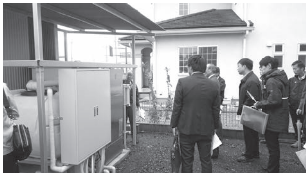
写真 1 地中熱利用システム現場見学会
