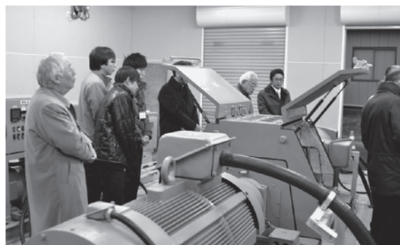
スマートグリッド実験施設内にあるコージェネ模擬用発電機
